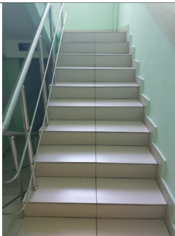
Фото № 42 Межэтажная лестница внутри здания
