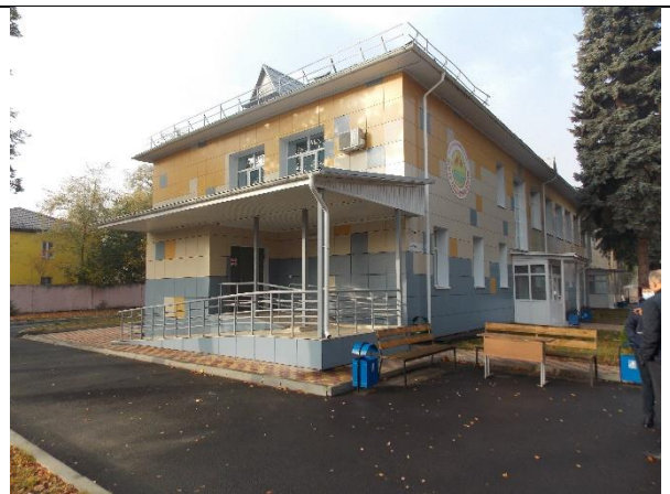
Фото № 6 Адаптированный вход в здание - вход, приспособленный для прохода маломобильных посетителей, в том числе на креслах-колясках
