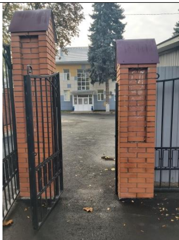
Фото № 2 Входная калитка
