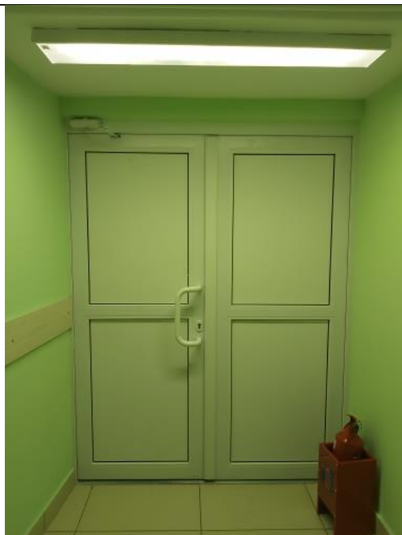
Фото № 38 Эвакуационный выход
