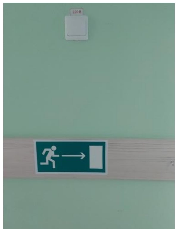
Фото № 75 Фотолюминесцентные эвакуационные указатели
