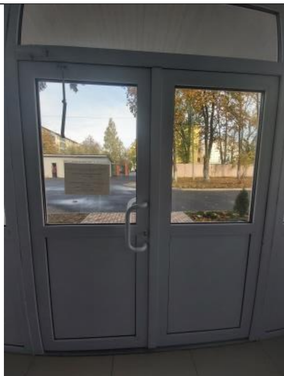
Фото № 39 Эвакуационный выход
