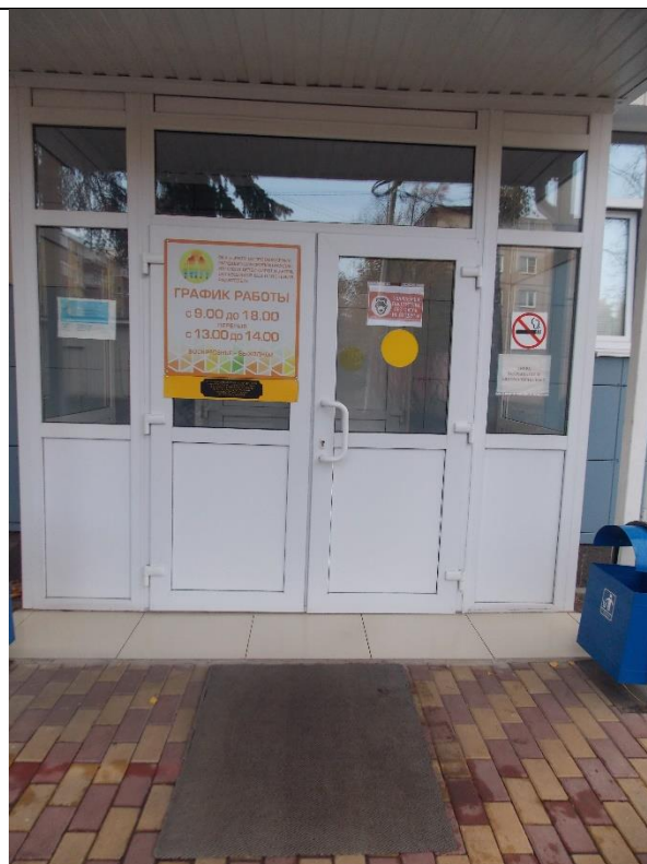
Фото № 8 Входная дверь главного входа
