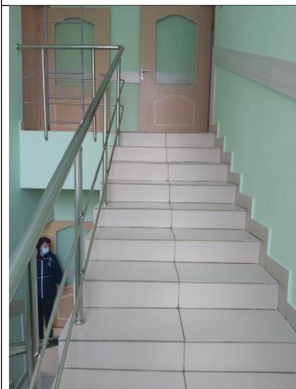
Фото № 43 Межэтажная лестница внутри здания
