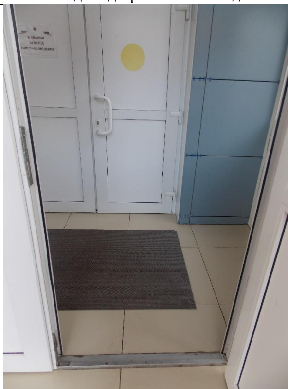
Фото № 10 Тамбур главного входа
