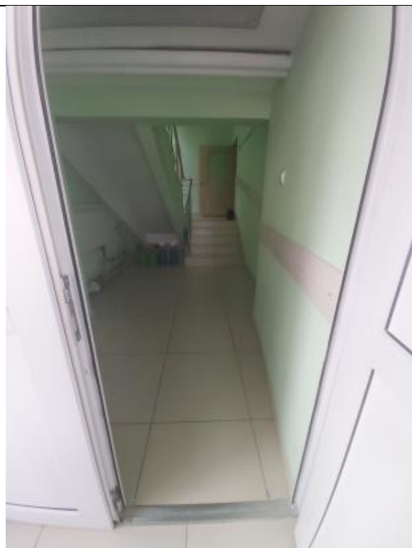
Фото № 40 Дверь эвакуационного выхода
